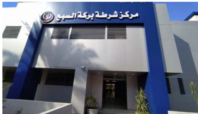
قسم شرطة بركة السبع / المنوفية — الواجهة الرئيسية
